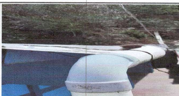
Foto 6: Sustrucción de canal de PVC + Sustrucción de bajada de agua pluvial de metal por tubo PVC 3" + Sustrucción de soporte o pescante de metal para canal
