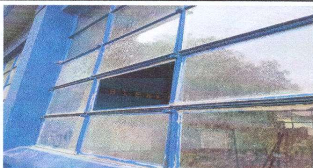
Foto 3: Sustrucción de vidrios
